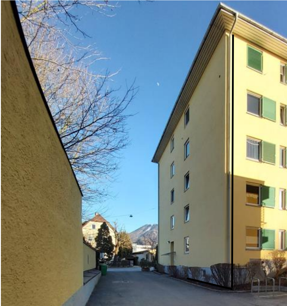
Die Kabelverlegung/Kanal vom Dach zum Kellergeschoss erfolgt außen.
