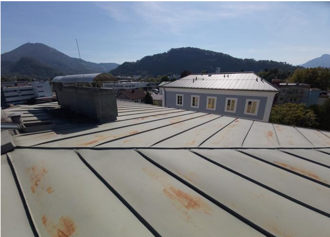
Dach der Wohnanlage Bayerhamerstraße 59 - Ansicht Richtung Westen (rechts im Bild: Südseite)
