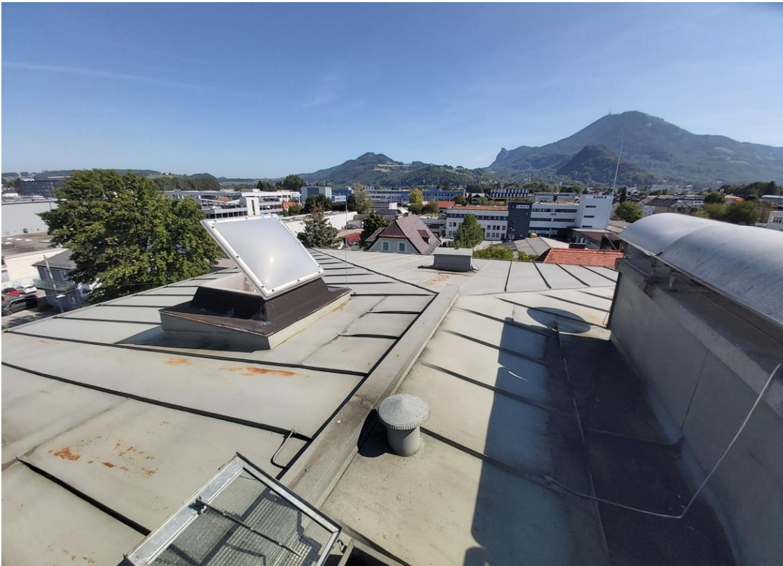
Dach der Wohnanlage Bayerhamerstraße 59 - Ansicht Richtung Westen (links im Bild: Nordseite)
